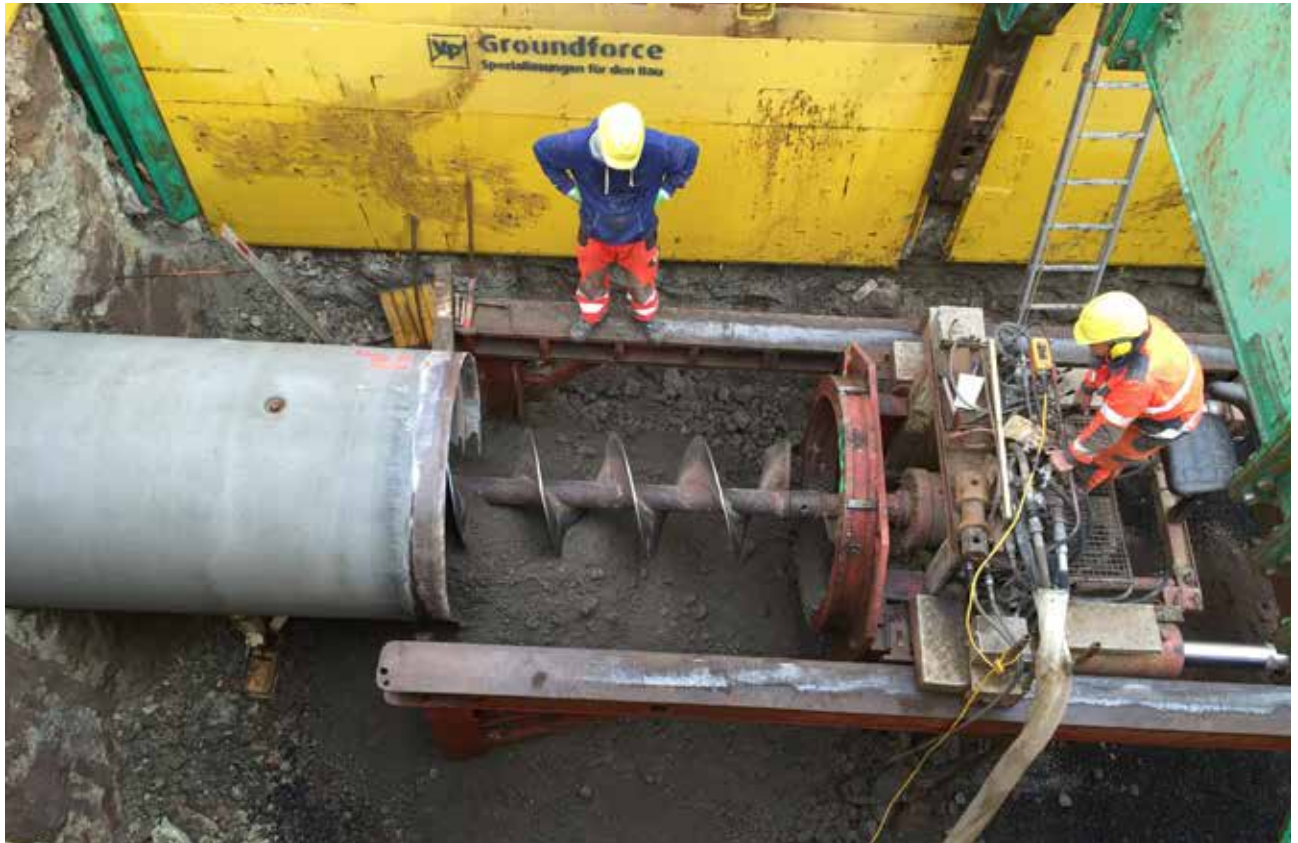
Die Arbeiten sind in vollem Gange.
