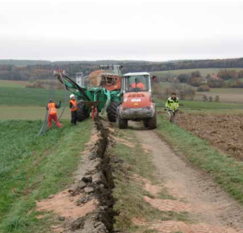
Bauarbeiten zum Anschluss an das Stromnetz der ovag Netz AG
