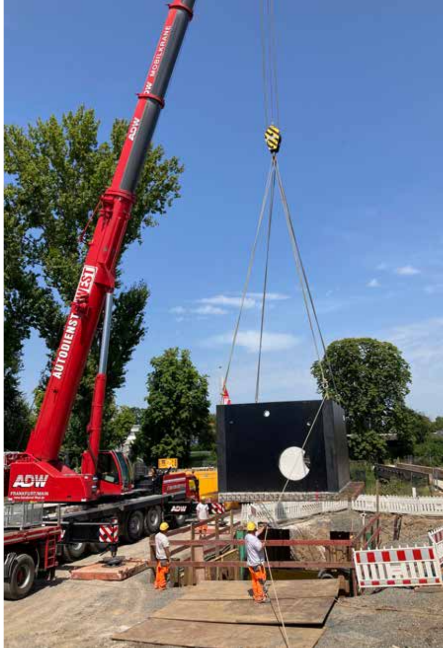
Per Kran wird das Schachtbauwerk eingehoben (rechts). Die Leitungen sind 80 Zentimeter dick (Mitte, oben) und werden vor der Umbindung verschweißt (links). Die Startgrube für die Tunnelbohrung liegt einige Meter tief (Mitte, unten).
