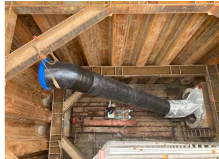
Per Kran wird das Schachtbauwerk eingehoben (rechts). Die Leitungen sind 80 Zentimeter dick (Mitte, oben) und werden vor der Umbindung verschweißt (links). Die Startgrube für die Tunnelbohrung liegt einige Meter tief (Mitte, unten).
