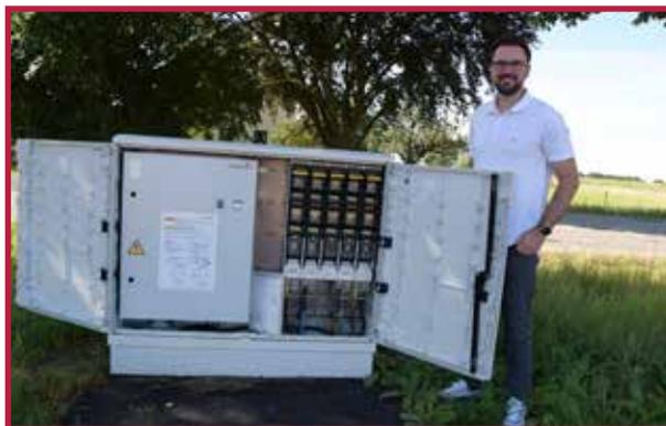
Die ovag Netz GmbH setzt Niederspannungslängsregler als punktuelle Alternative zum Netzausbau ein, unter anderem mit Niederspannungslängsreglern wie in Schwalmatal-Rainrod, Hungen und hier in Beienheim.
